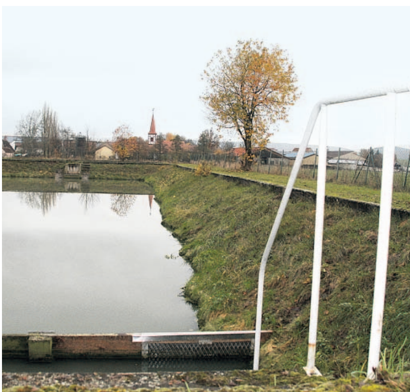
Die nördlichen Ortsteile sollen an die zentrale Abwasseranlage angeschlossen werden. Im Bild: der „Schönungsteich“ der Kleinkläranlage in Berolzheim. Fotos: Bergmann
